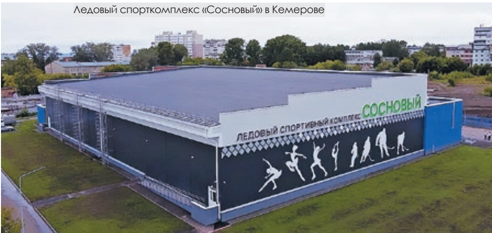
Ледовый спорткомплекс «Сосновый» в Кемерово
